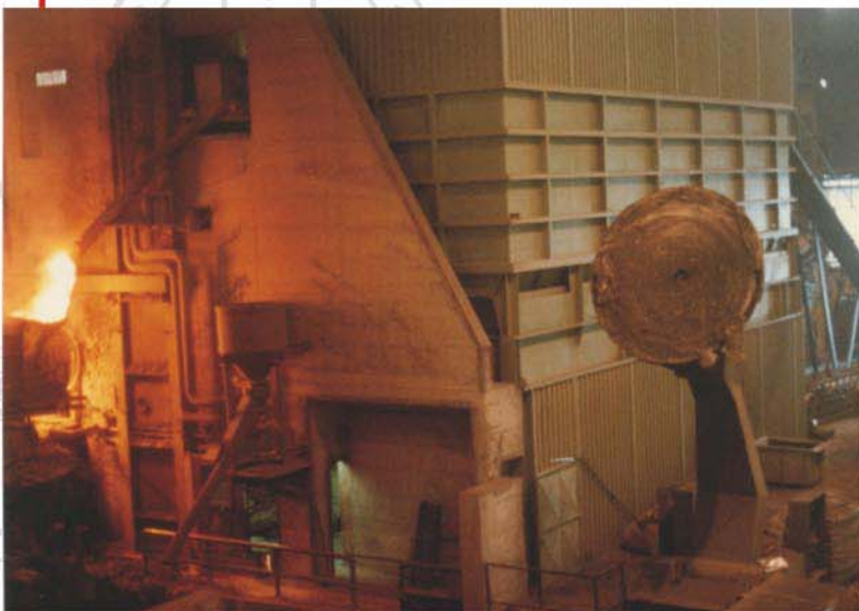
Impianto additivi con stoccaggio e dettaglio dello scivolo di scarico in forno e della tramoggia additivi per la siviera
